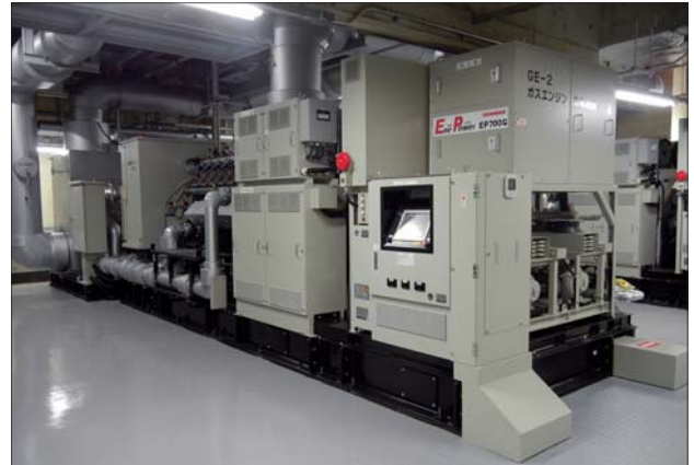
写真4 東京工科大学で稼働する2000kW規模（700kW×3台）のCO 2 圧縮装置
