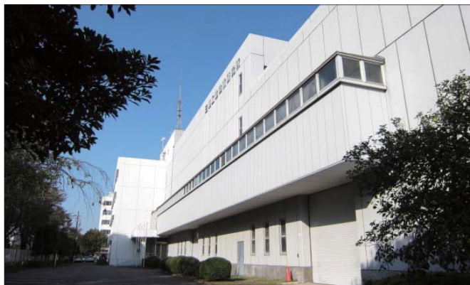
写真2 三機工業株式会社 技術研究所
